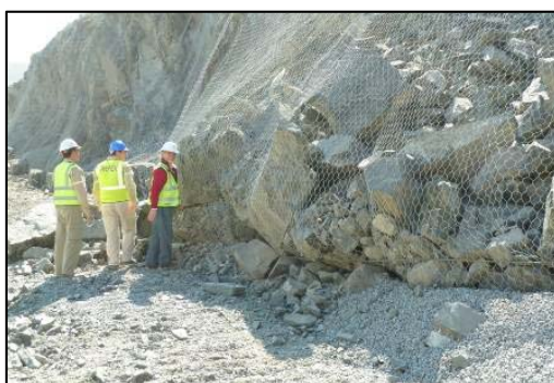
Figura 2 Esempio di detriti accumulate alla base di un sistema di reti rivestimento fissato alla base.
