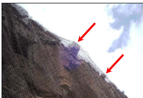
Figura 6 Esempio di rivestimento pesante (HEA pannello di cavi, peso > 2.0 kg/m 2 ): la rete permette di trattenere i blocchi lungo il pendio (freccie rosse).
