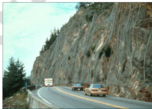
Esempio della protezione Rete Paramassi
