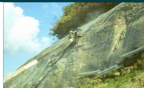
Esempio della protezione Rete Paramassi
