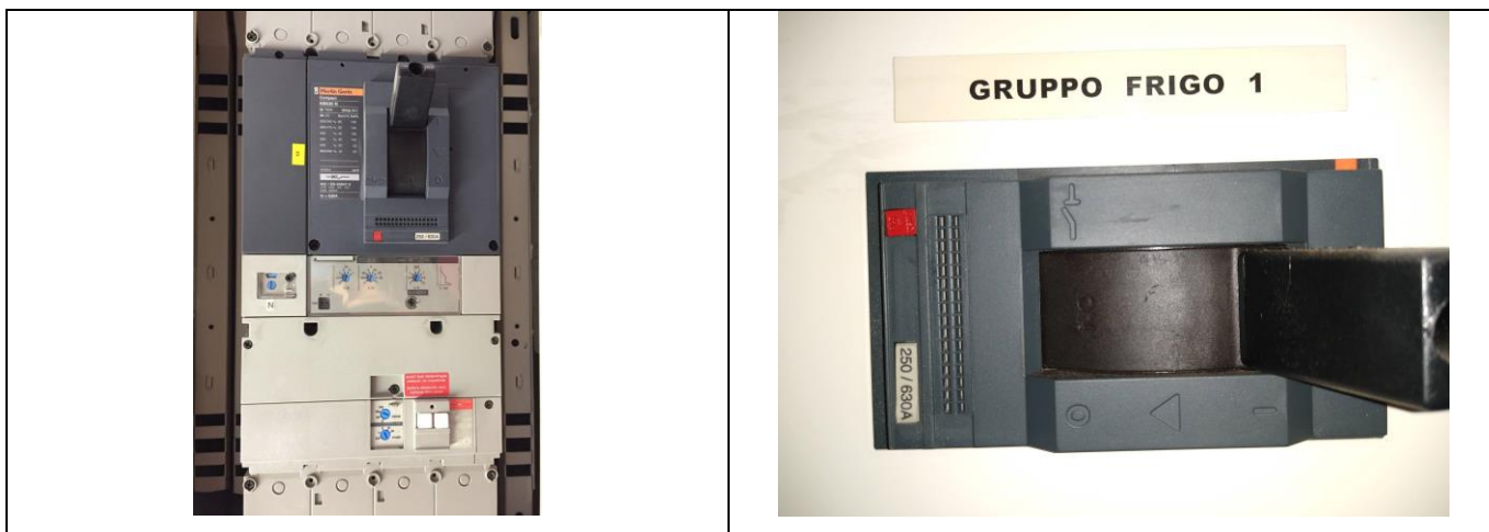
Foto 1: Interruttore interno al Quadro elettrico BT Cabina Elettrica
