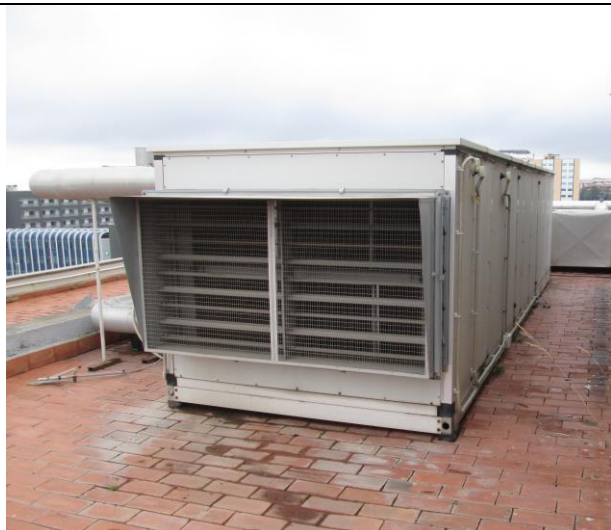
Foto 2a: Individuazione dell U.T.A. esistente da 16.000 mc/h
