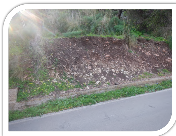
Foto 11 - Scarpate non protette soggette a fenomeni di erosione (37.935779 N - 13.610794 E)
