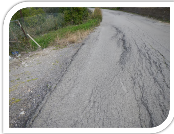
Foto 8 - Ammaloramento sovrastruttura stradale
