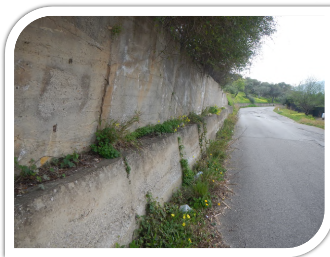
Foto 2 - Crisi statica di muro di contenimento prossimo al punto della foto 1 (37.983320 N -13.628517 E)
