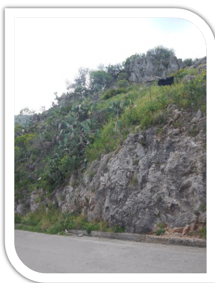
Foto 4 - Tratto con assenza di protezione per crolli di blocchi lapidei (37.993261 N -13.638552 E )
