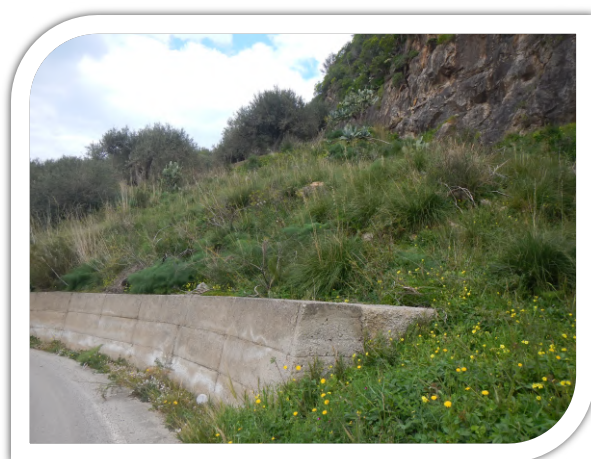
Foto 5 - Tratto con inadeguata protezione da crolli di blocchi lapidei (37.977309 N -13.629579 E )
