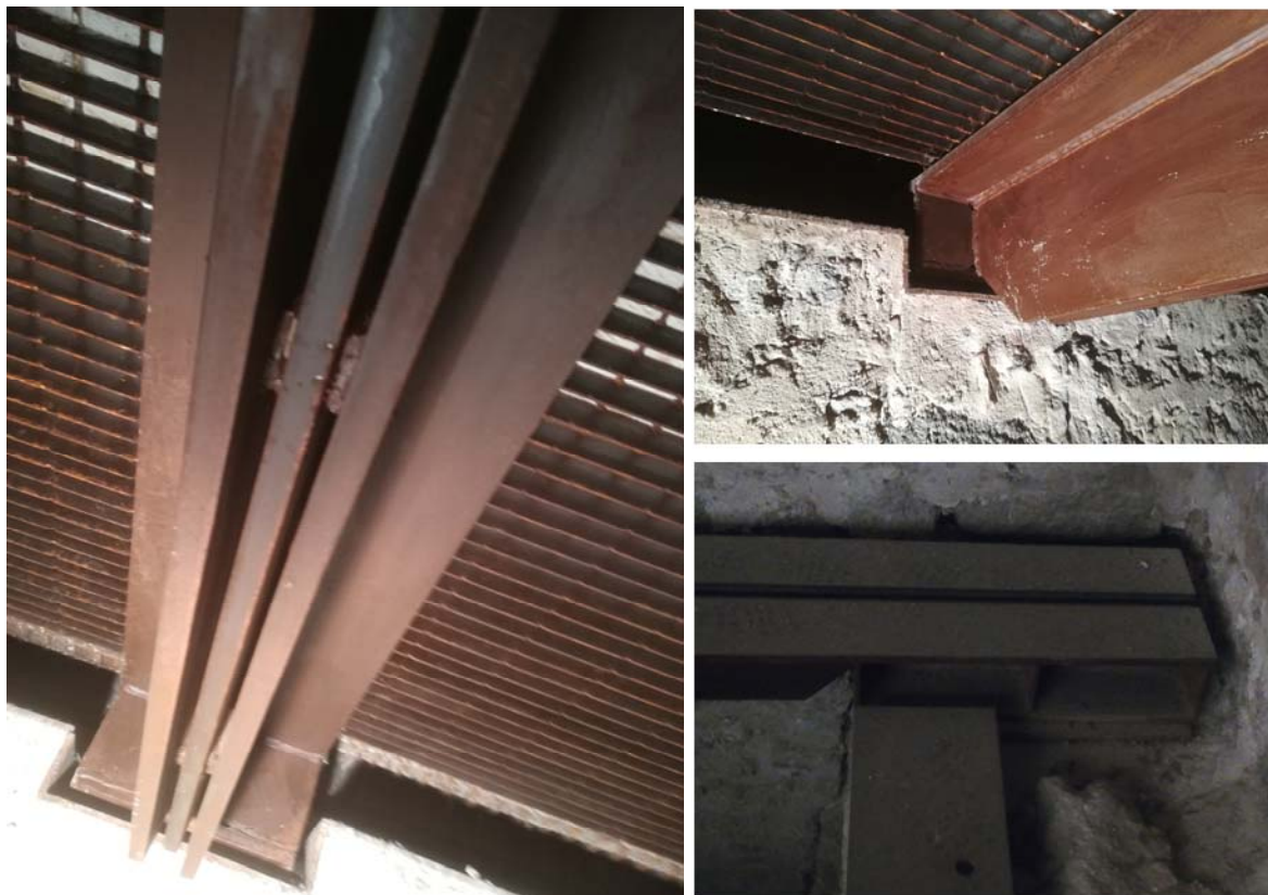
Particolare del solaio del 1° livello – Struttura portante e sistema di appoggio della trave principale.
