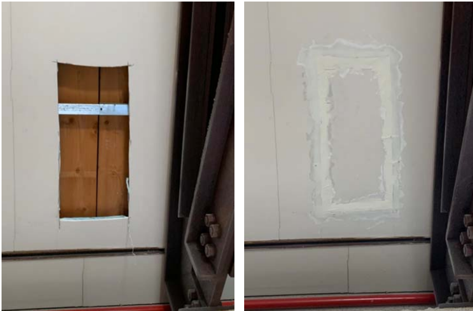
Foto n° 15 – Traccia edile su copertura – Rimozione e successivo ripristino della porzione di cartongesso
