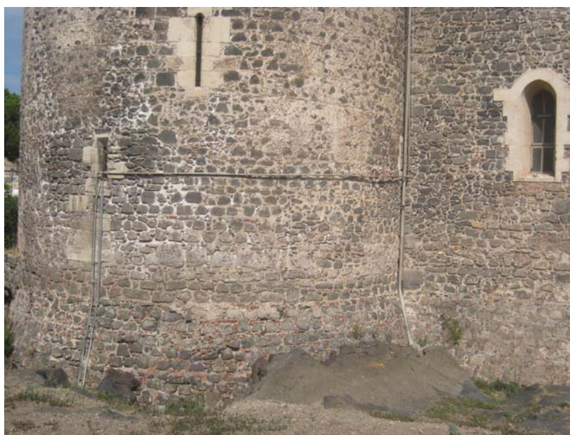
Tipologia muratura portante in evidenza
