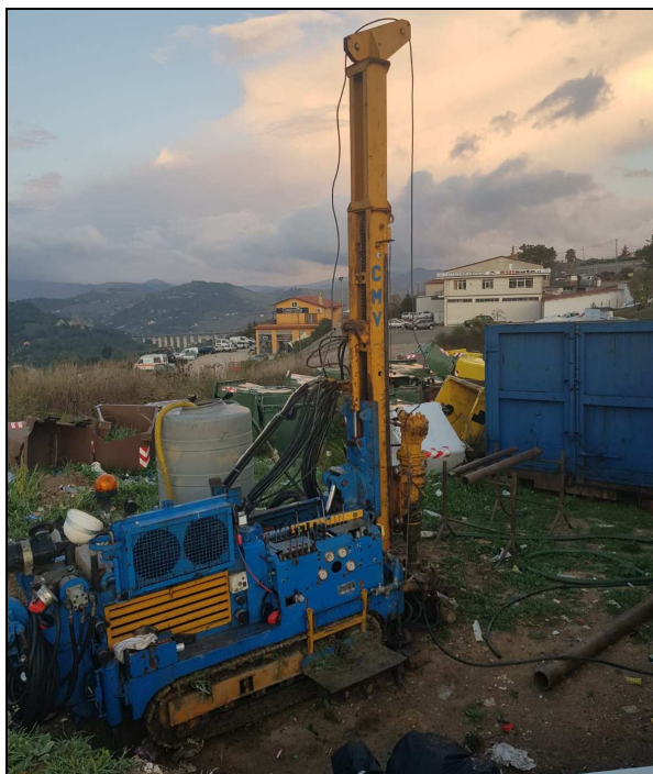
Foto n 1 - sonda oleodinamica CMV 420
