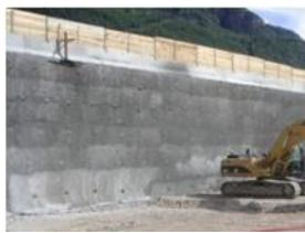
Il lavoro consiste nell'esecuzione di paratie di sostegno costituita da pannelli monolitici in cls armato, di diverso spessore ed altezza, mediante l'ausilio di specifiche macchine.
