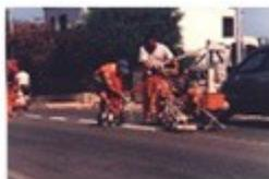
Trattasi della verniciatura della segnaletica orizzontale stradale eseguita mediante compressore a spruzzo manuale o su automezzo speciale. In particolare si prevede:
