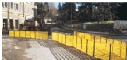
Si prevede la realizzazione della recinzione di cantiere sia con paletti di ferro o di legno e rete di plastica arancione, sia con pannelli prefabbricati in alcune zone del cantiere. I paletti saranno infissi nel terreno per mezzo d'idonea mazza di ferro. Si prevede l'installazione di idoneo cancello realizzato fuori opera, in legno o in ferro, idoneo a garantire la chiusura (mediante lucchetto)
