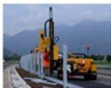
Si procede alla tracciatura degli interassi e alla preparazione delle sedi di alloggiamento dei montanti mediante battipalo.
