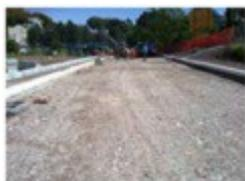
Si prevede la posa in opera di strati di misto granulare stabilizzato, ottenuto dalla selezione di ghiaie alluvionali di natura mineralogica prevalentemente calcarea, con aggiunta eventuale di pietrisco, per la costruzione della fondazione stradale ad elevata capacità portante, per gli ultimi strati dei rilevati sottostante le pavimentazioni, applicato in strati costipati di spessore non inferiore a 10 cm e non superiori a 30 cm.
