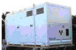
Si tratta di un generatore di tensione elettrica basato sul principio della forza elettromotrice prodotta dall'induzione elettromagnetica che si determina tra un circuito elettrico fisso e un circuito elettrico mobile che è posto in rotazione da un motore diesel.
