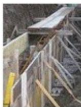
Operazioni di disarmo delle armature provvisorie di sostegno delle strutture portanti in cemento armato.
