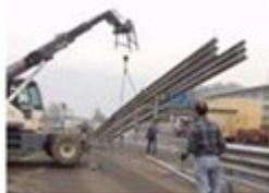
I componenti del guard-rail vengono trasportati nei cantieri a bordo di autocarro e divisi in montanti e correnti (tutti di dimensioni standardizzate); le operazioni di carico e di scarico vengono solitamente eseguite con l'ausilio di un mezzo di sollevamento.
