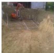
Trattasi della esecuzione, mediante idonei mezzi meccanici, di scavi a sezione obbligata in terreni di diversa natura, di profondità maggiore di m 1.50, arrivando ad una profondità di progetto di circa 5 metri.
