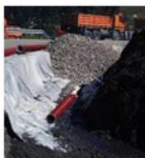
Trattasi della posa di materiale drenante, costituito da pietrame a granulometria variabile, posto a ridosso delle opere di sostegno in c.a., che permette l'intercettazione dell'acqua ed il suo drenaggio, fino allo scolo tramite opportune tubazioni drenanti poste ad un determinato interasse.
