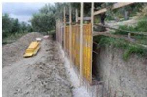
Trattasi della preparazione, taglio e posa in opera di casseforme per le pareti in elevazione dei muri di sostegno in c.a. In particolare si prevede:
