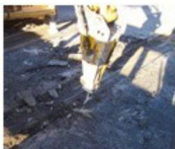
L'attività consiste nella scarificazione, taglio e rottura di massicciata stradale consolidata con mezzi meccanici (fresatrice, martello demolitore o simile) ed attrezzi manuali di uso comune.
