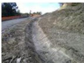
Trattasi della realizzazione dei fossi di guardia, a monte ed a valle delle opere di sostegno; il lavoro comprende, altresì, la messa in opera di pozzetti prefabbricati in cls.
