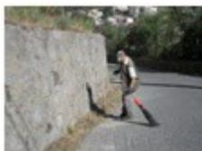
Attività di rimozione di arbusti e simili dai bordi delle strade ed in corrispondenza di barriere di sicurezza e spartitraffico, eseguita con attrezzi manuali o con l'uso di decespugliatore. In particolare si prevede:
