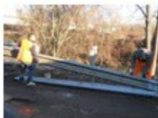
Si procede alla rimozione di vecchie barriere stradali incidentate, lame e paletti, rimuovendo i fissaggi al terreno e sfilando le barre trasversali.
