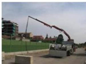
Dopo aver posto in opera i montanti, che normalmente sono costituiti da profilati metallici a doppio T, si provvede a movimentare e posizionare le barriere (a doppia o tripla onda) manualmente, nel caso in cui la dimensione ed il peso della barriera lo permetta, oppure mediante l'ausilio di gru su autocarro.
