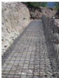
Esecuzione delle cassature al piano di fondazione, posa delle armature e getto, mediante autobetoniera, della trave di fondazione in conglomerato cementizio armato.
