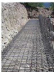
Esecuzione del getto di magrone di pulizia scavo, sul quale verrà posata l'armatura di fondazione. Il calcestruzzo sarà impastato in cantiere per l'impossibilità di accedere alla zona con autobetoniere.
