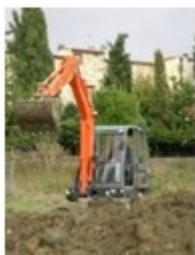
Trattasi dell'esecuzione di rinterri per lavori di diversa natura, quali riempimenti di scavi a sezione obbligata, ecc., eseguiti con mezzi meccanici con piccoli interventi manuali.
