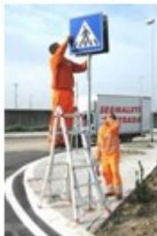
La fase lavorativa consiste nell'assemblaggio e posa della segnaletica verticale, in fori predisposti, mediante l'ausilio di scale, ponte su cavallette ed attrezzi manuali di uso comune.
