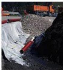
Trattasi della posa di materiale drenante, costituito da pietrame a granulometria variabile, posto alla base del muro, che permette l'intercettazione dell'acqua ed il suo drenaggio, fino allo scolo tramite opportune tubazioni drenanti poste ad un determinato interasse, allo scopo di ridurre la spinta dell'acqua.
