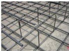
Operazioni di taglio e sagomatura dei ferri di armatura dei muri di sostegno in c.a., eseguite in area specifica attrezzata con l'ausilio di apposite trancia-piegaferri e relativa posa in opera. Si prevede:
