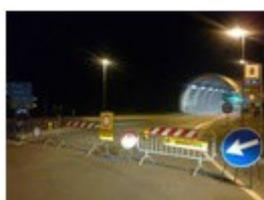
Posizionamento della dovuta segnaletica provvisoria (orizzontale e verticale) sulla carreggiata interessata dai lavori cantieristici, prima dell'ingresso in galleria (per segnalare i lavori) e lungo il percorso; tale operazione può avvenire una sola volta all'apertura del cantiere o può ripetersi quotidianamente all'inizio della giornata lavorativa.
