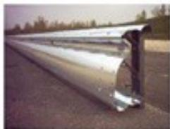
La fase lavorativa consiste nel montaggio dei correnti che sono fissati ai montanti a mezzo di appositi bulloni. Per la successiva serratura dei bulloni si interviene con una chiave dinamometrica montata su avvitatore pneumatico o elettrico.
