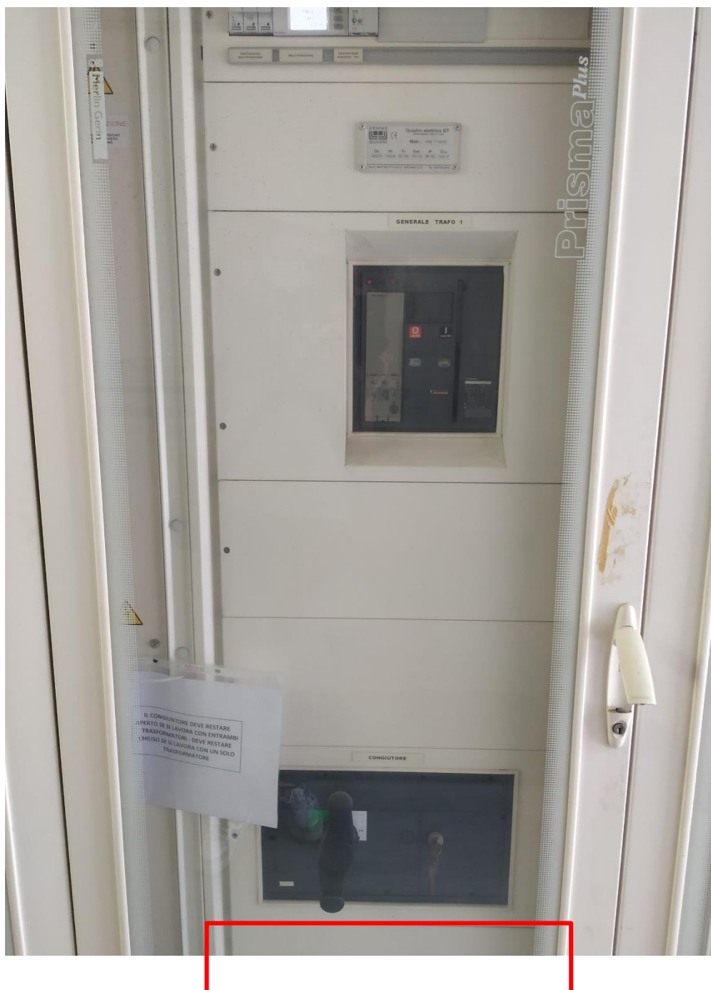
QUADRO GENERALE BT: NODO DI SCAMBIO
