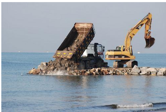
Costruzione del nucleo da terra.
