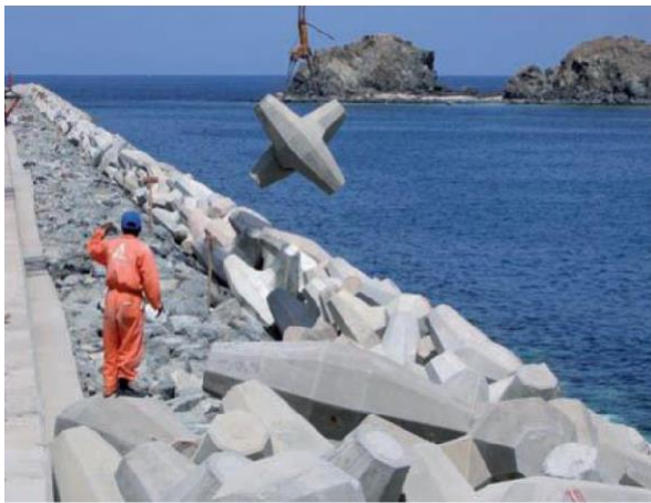
Esempio costruzione di mantellata
