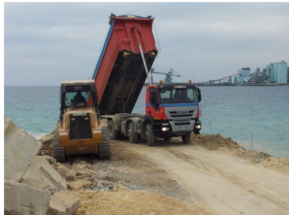
Costruzione del nucleo da terra.
