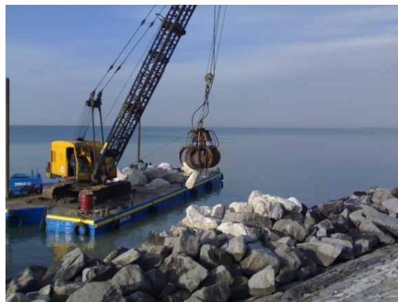
Costruzione strato filtro da mare.
