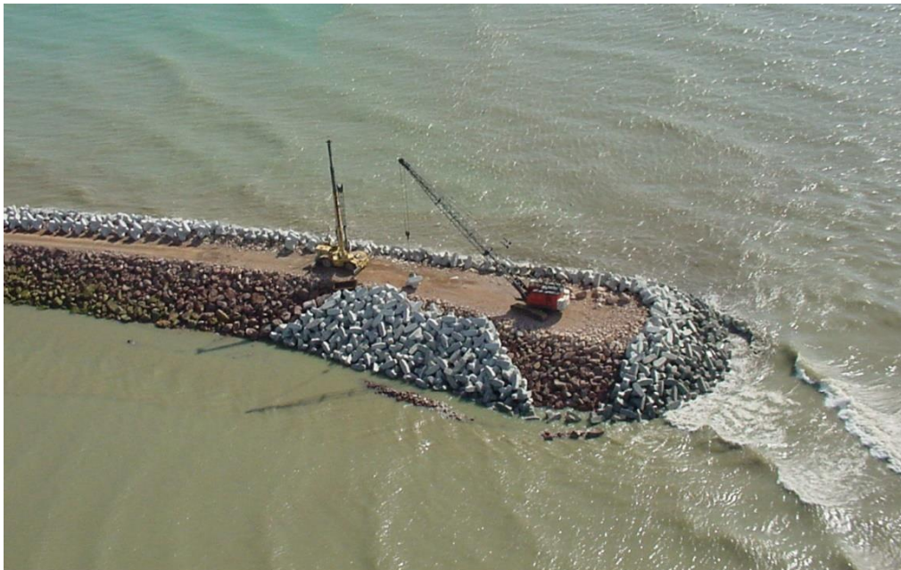
Dettaglio costruttivo mantellata in fase di costruzione.
