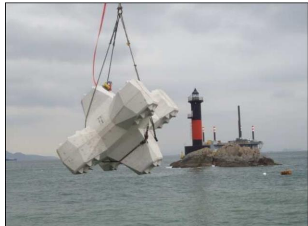
Particolare imbracamento blocco
