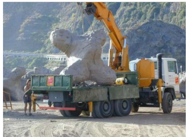
Operazione di carico di un masso su camion per il trasporto sino all'imbarco su pontone.
