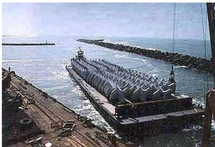
Massi caricati su pontone, pronti per essere messi in opera.
