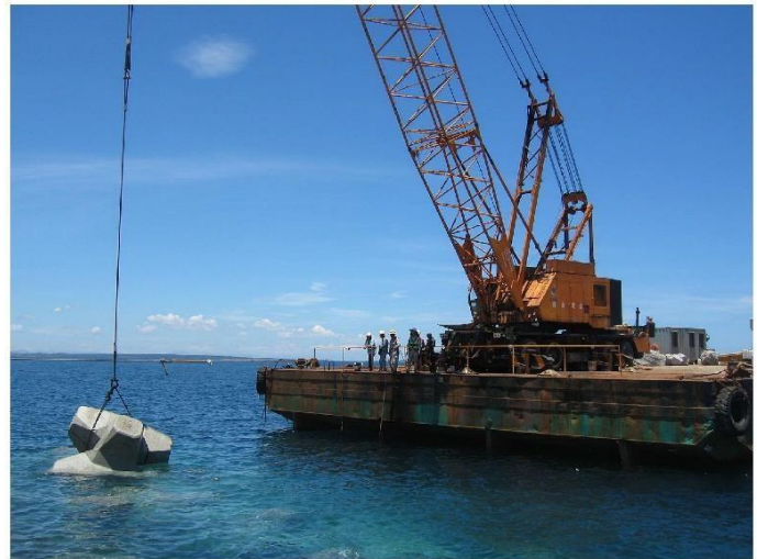
Esempio posa in opera singolo ELEMENTO in calcestruzzo a mezzo pontone galleggiante munito di gru.
