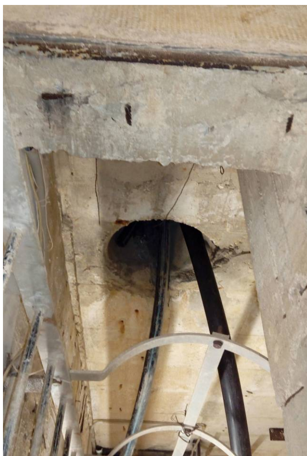
Figura 3 – Foro di passaggio condotta premente
