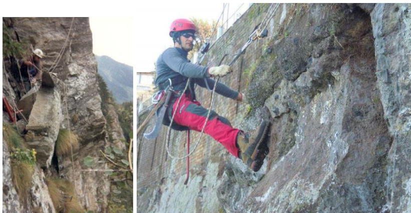
-Fig. 9 fase di disgreggio e pulizia
