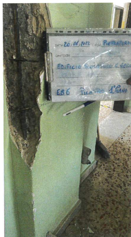
Fig. 54: Estrazione barra EB6
