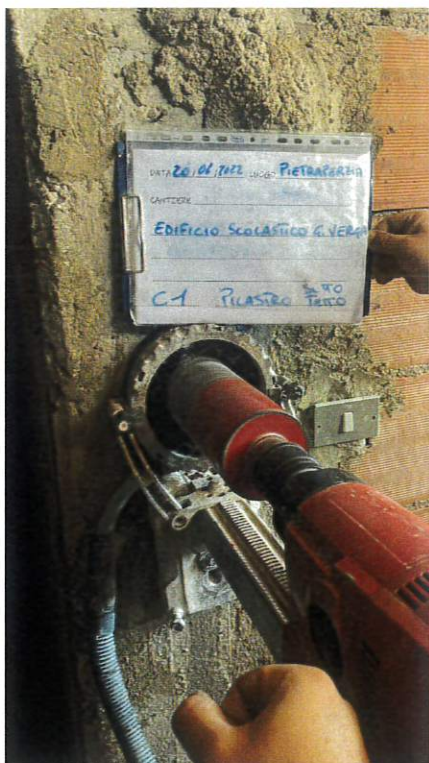
Fig. 1: Estrazione carota C1
