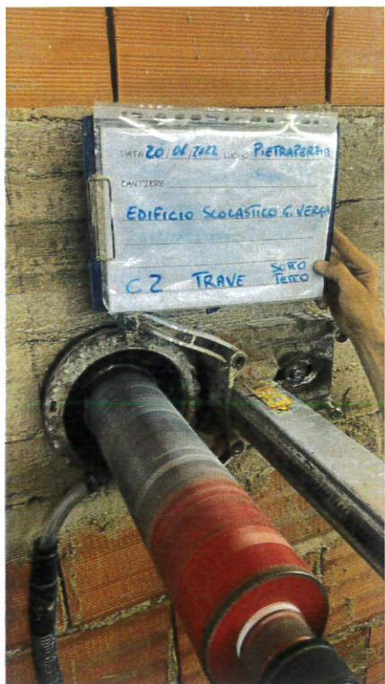
Fig. 3: Estrazione carota C2
