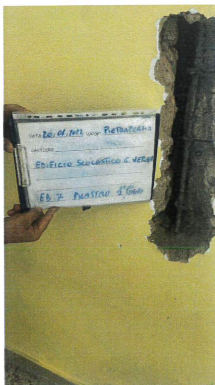
Fig. 55: Estrazione barra EB7
