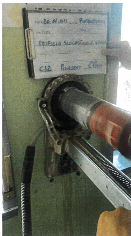
Fig. 23: Estrazione carota C12
