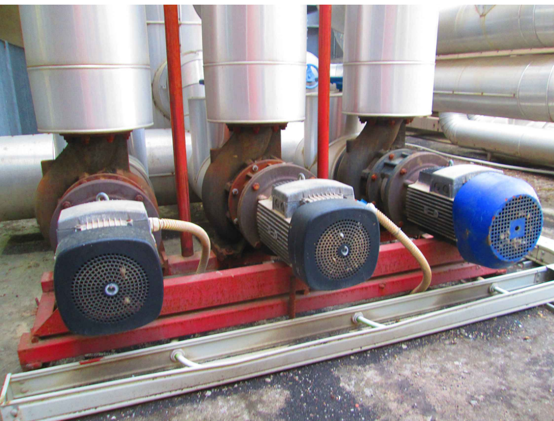
Elettropompe di Circolazione Esistenti
