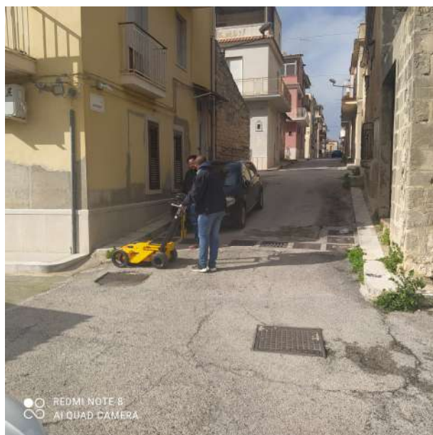
Foto N°11 – Rilievo georadar di Via L. Molino
