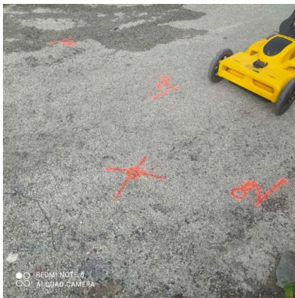
Foto N°13 – Rilievo georadar marcatura punto sondaggio di Via L. Molino
