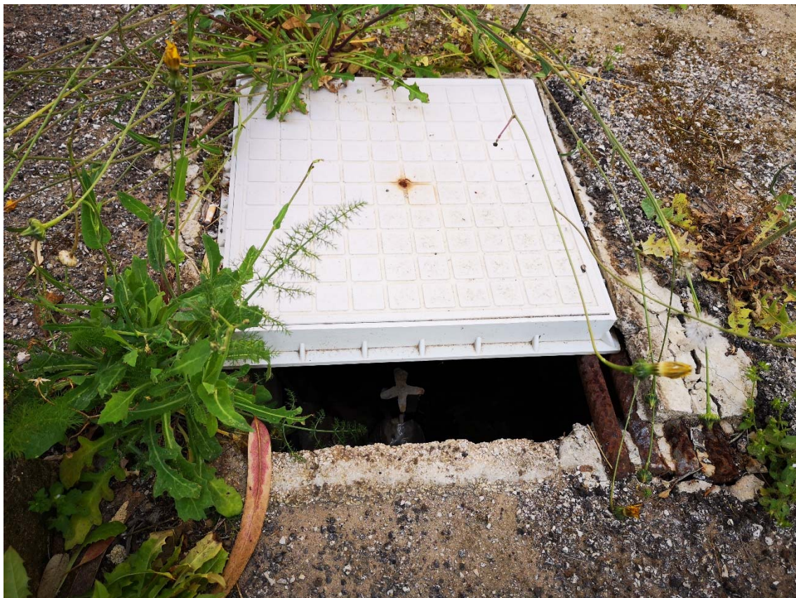
Foto n.17 Particolare pozzetto impianto di terra
