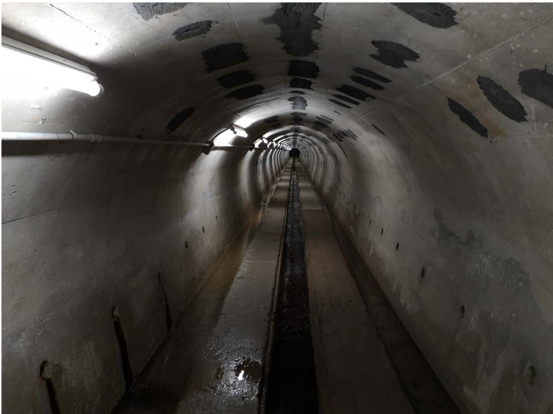
Foto n.26 Particolare umidità su componenti illuminazione cunicoli drenaggi
