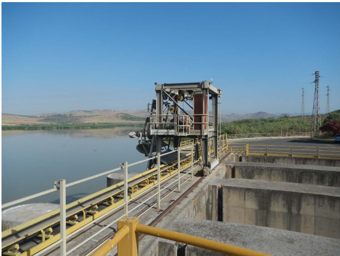
Foto n.22 Quadro di comando paratoia tipo
