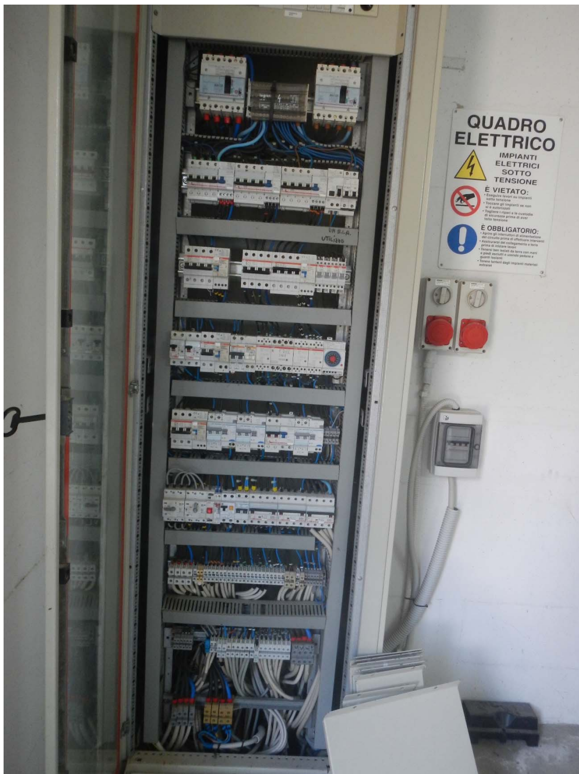
Foto n.24 Particolare cablaggio interno Quadro generale
