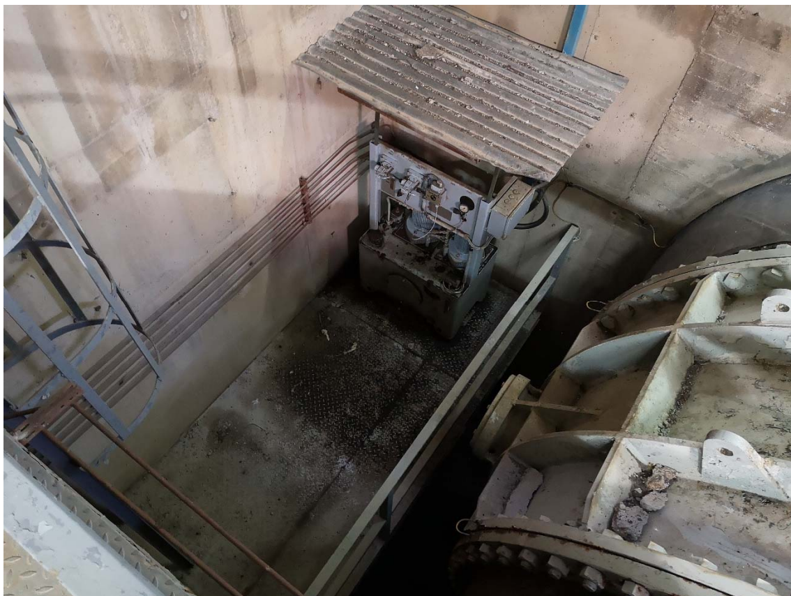
Foto n.34 Quadri pozzi di manovra valvole
