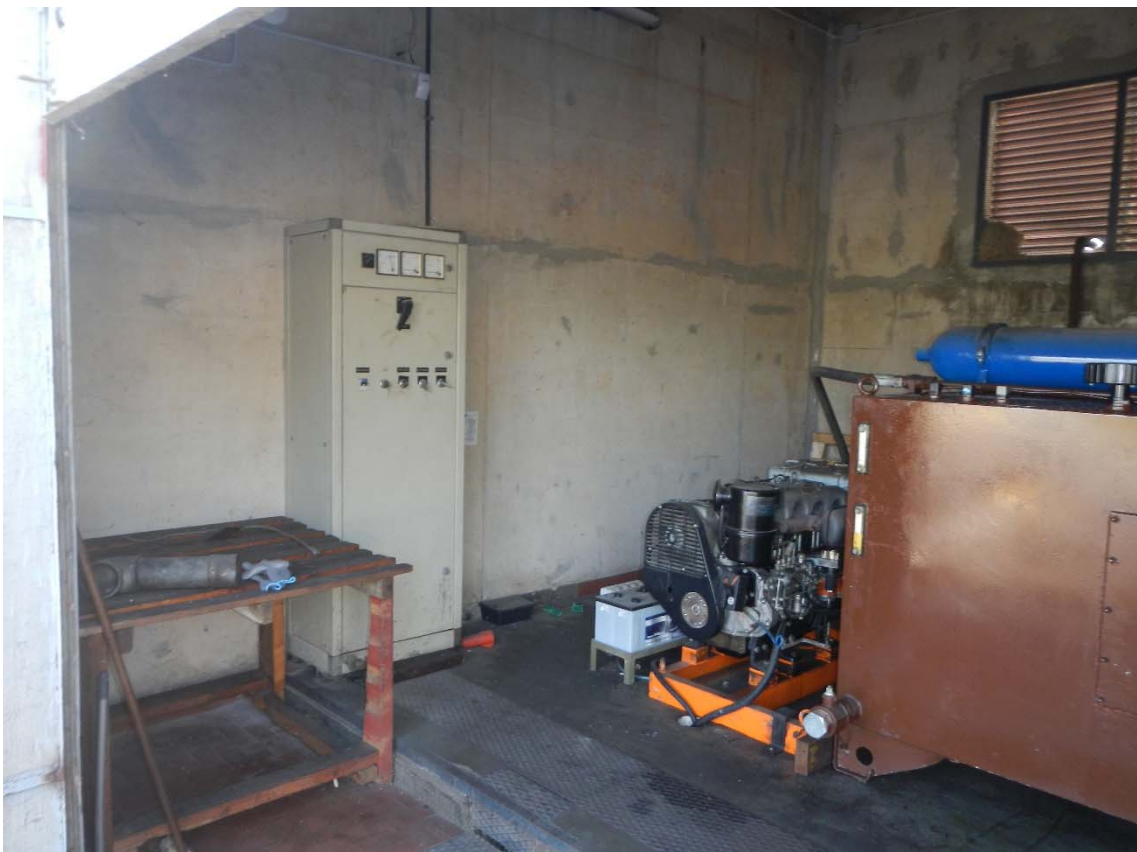
Impianto oleodinamico comando paratoie 1-4
