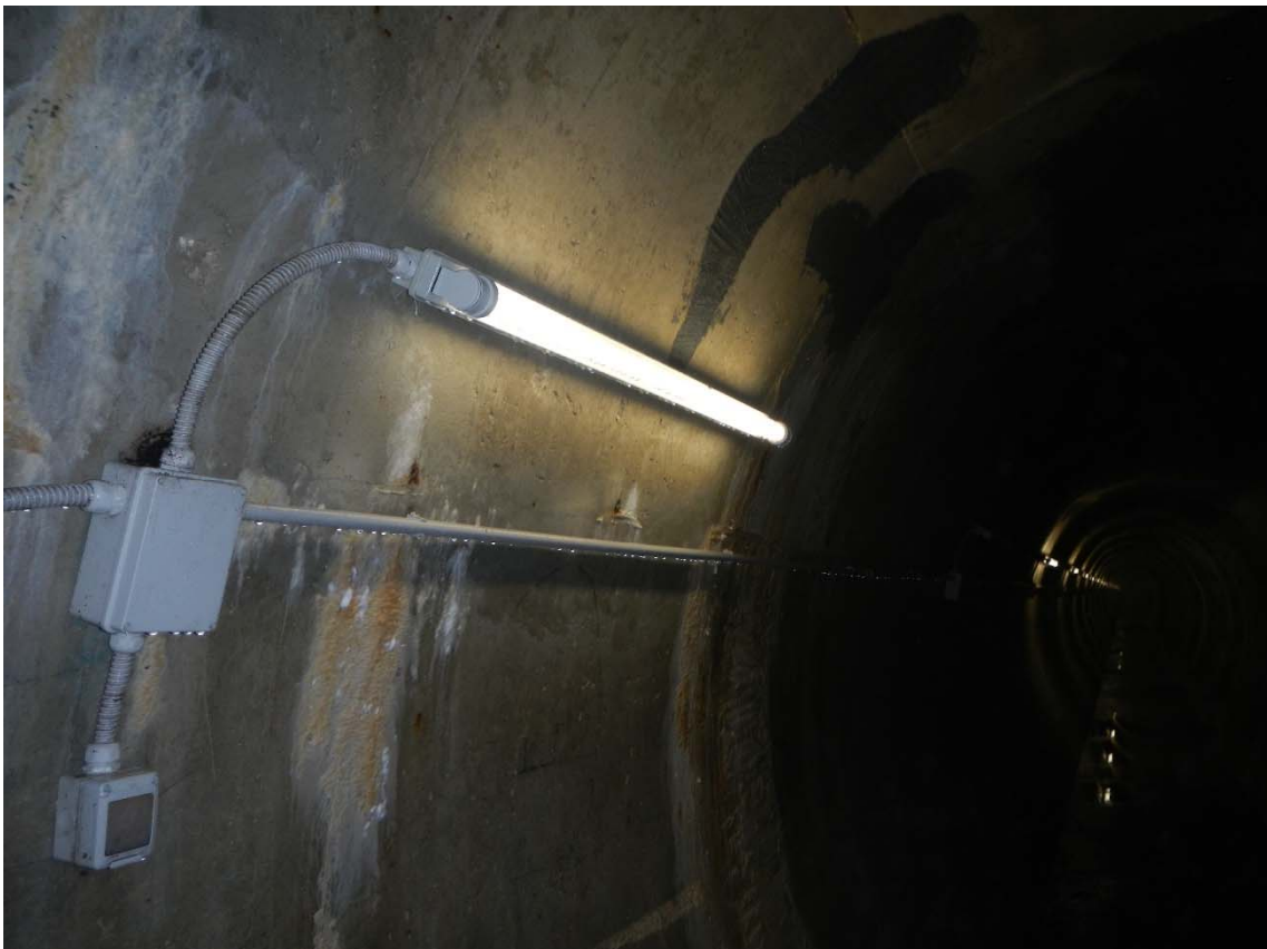
Foto n.26 Particolare umidità su componenti illuminazione cunicoli drenaggi
