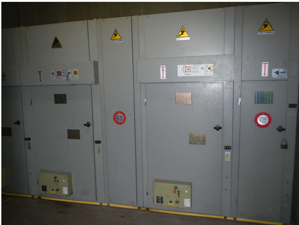
Foto n.16 Quadro di Bassa Tensione
