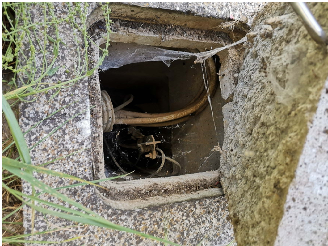
Foto n.37 Pozzetto di arrivo linea quadro pompe
