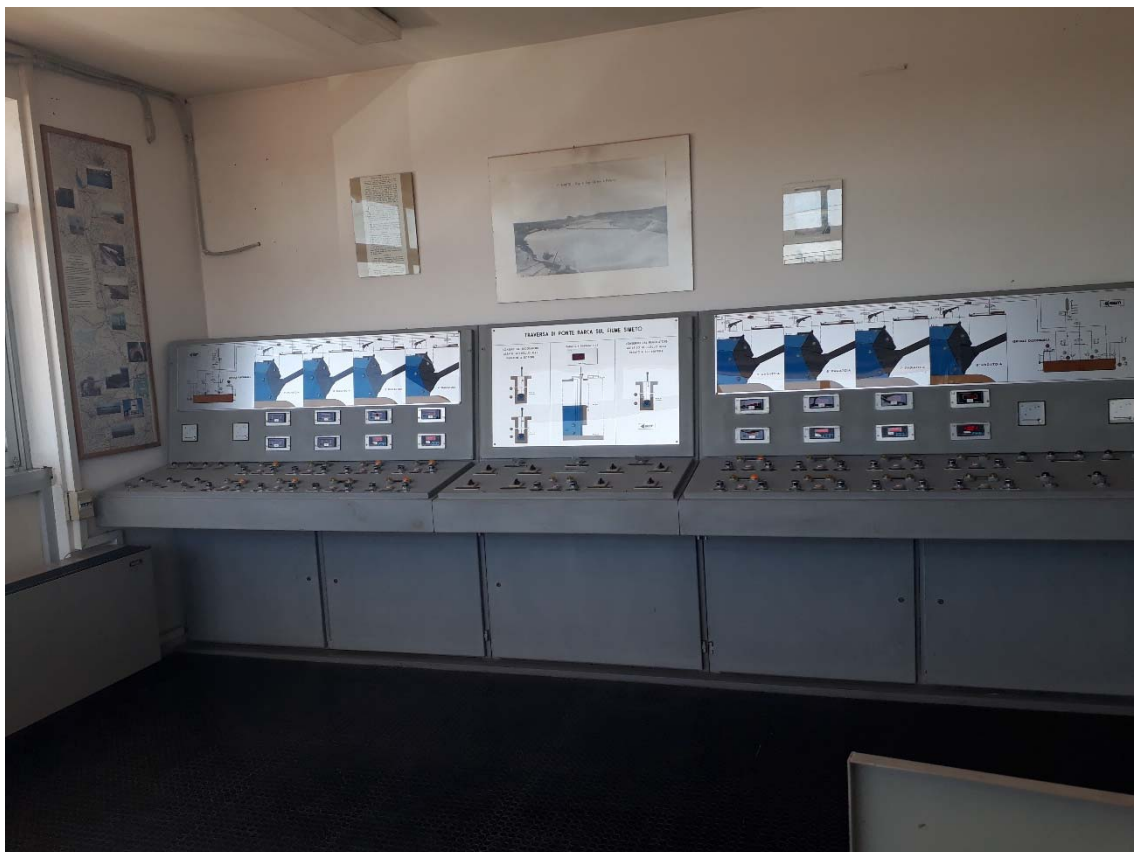
Foto n.38 Quadro sinottico traversa
