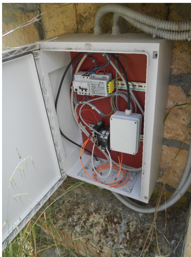
Foto n.60 Particolare quadro venturimetro
