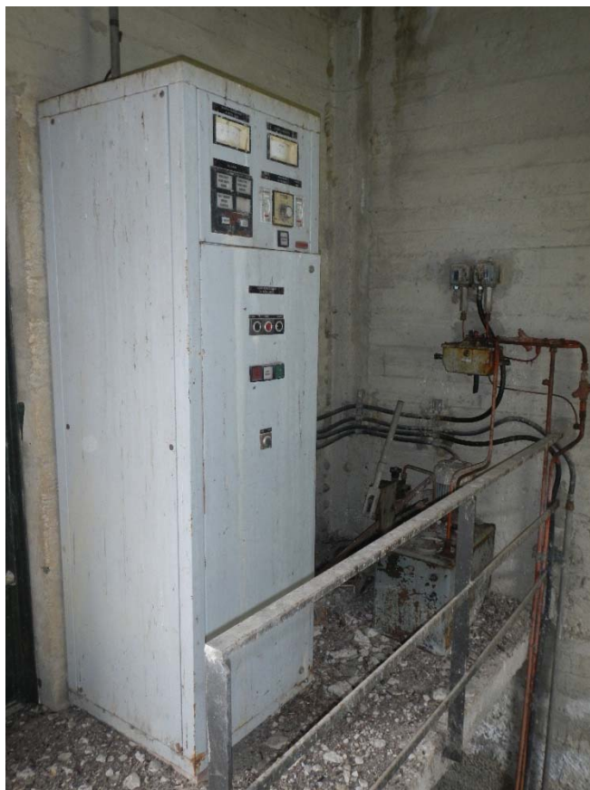
Foto n.56 Quadro flussostato canale di scarico
