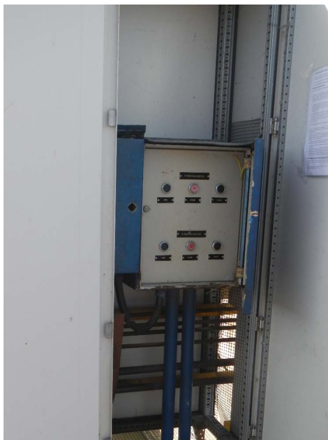
Foto n.22 Quadro di comando paratoia tipo
