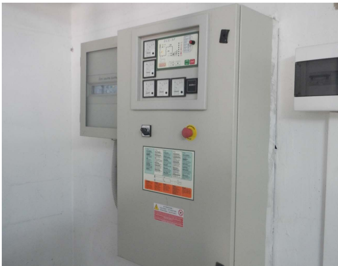
Foto n.30 Quadro di avviamento gruppo elettrogeno
