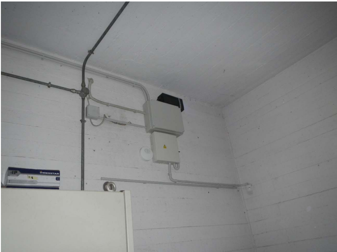
Foto n.18 Gruppo di continuità impianto antintrusione
