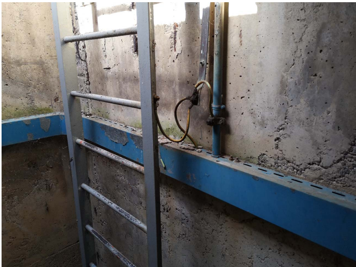
Particolare collegamento di terra su scala pozzi di manovra valvole
