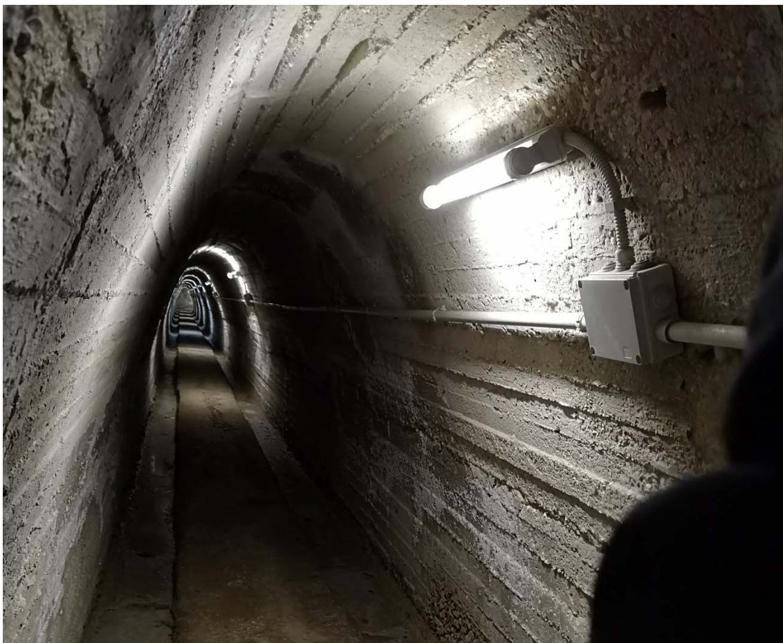
Foto n.40 Particolare tubazione corpi illuminanti cunicoli drenaggi
