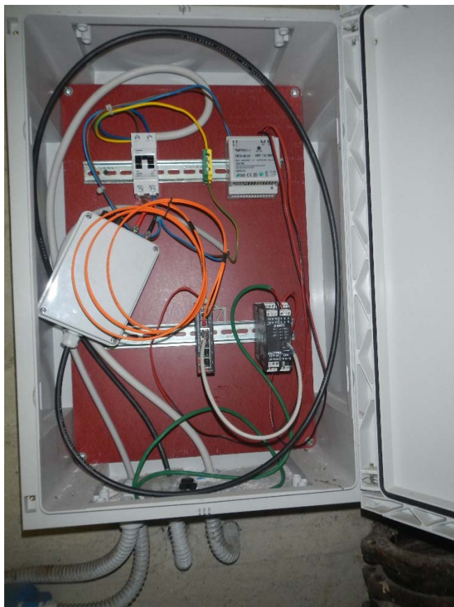
Foto n.56 Quadro flussostato canale di scarico
