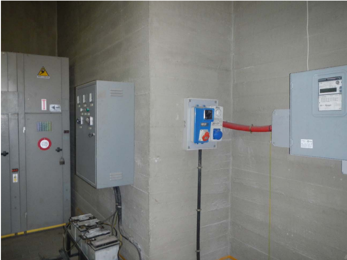
Foto n.18 Gruppo di continuità impianto antintrusione
