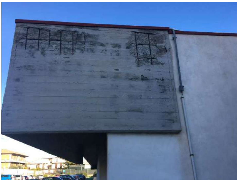
Foto 3 - degrado cornicione prospetto nord
