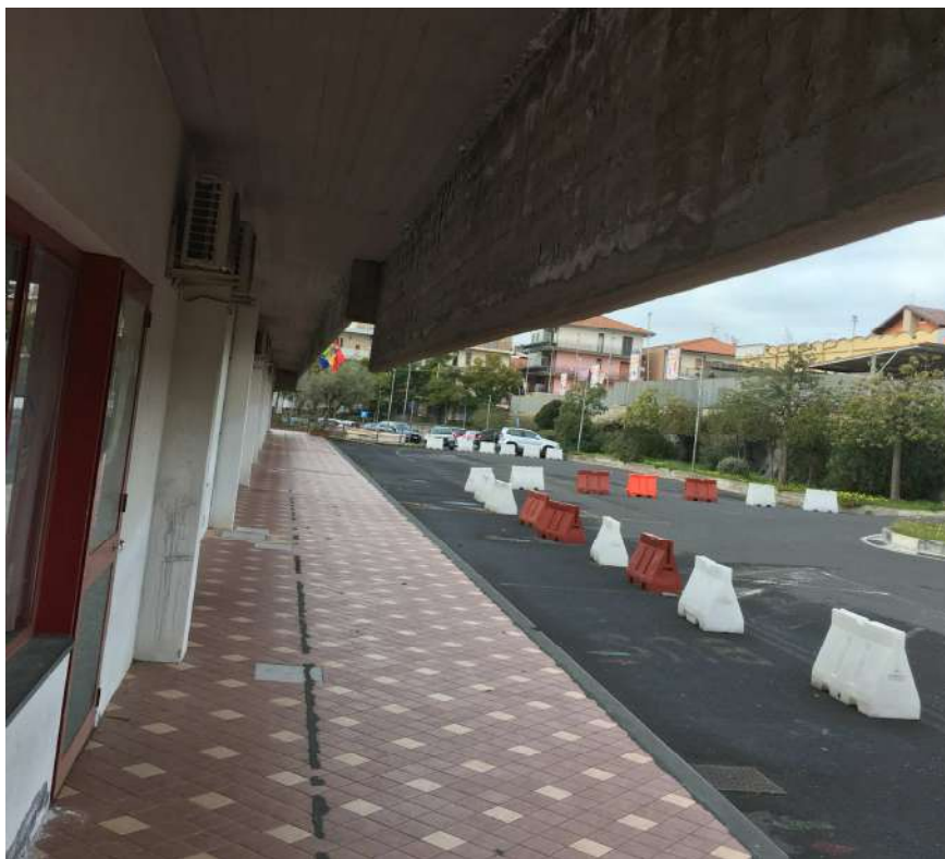
Foto 2 - degrado cornicione prospetto nord
