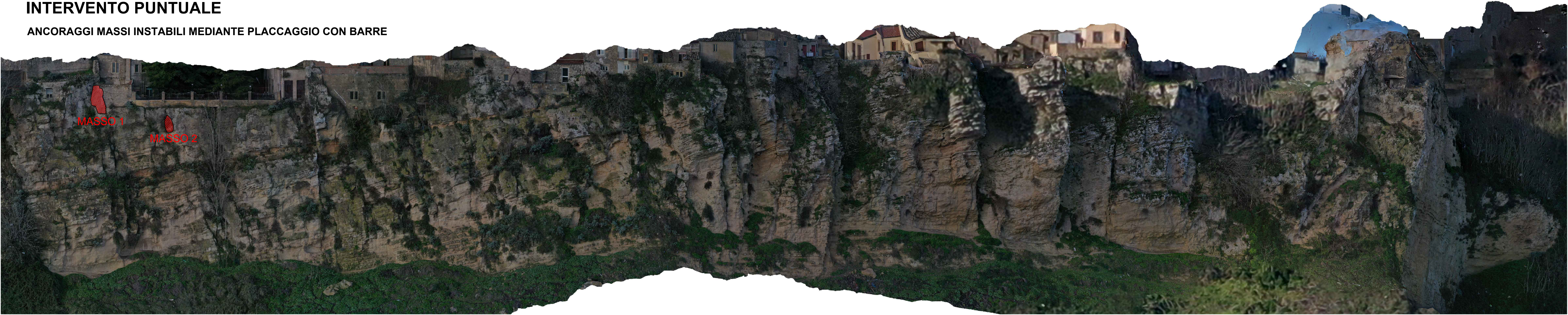
Vista frontale della parete con individuazione dei massi instabili
