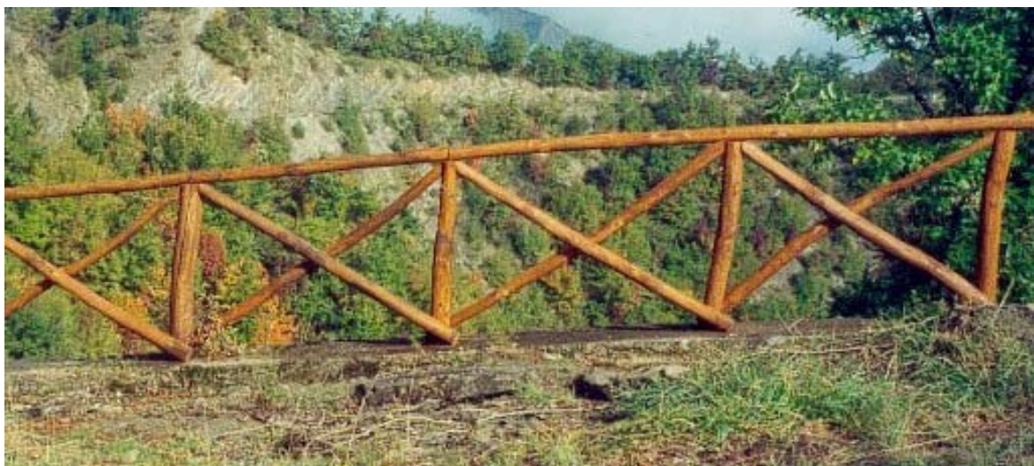
Tipologia 1 di staccionata con correnti incrociate inserita in progetto:
