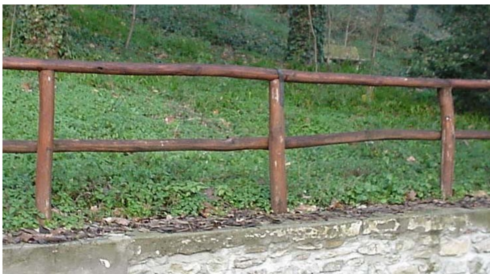
Tipologia 2 di staccionata con correnti orizzontali inserita in progetto:
