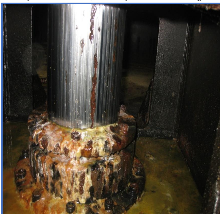
Figura 18 - Vista dettagliata dello stelo di movimentazione della paratoia di monte
