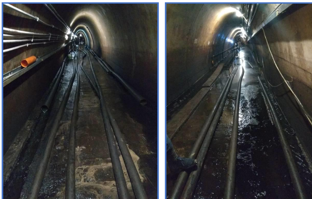
Figura 19 - Collettori raccolta perdite e tubazioni di mandata
