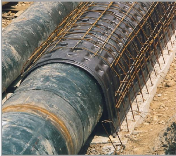
Foto metanodotto durante il montaggio del cunicolo
