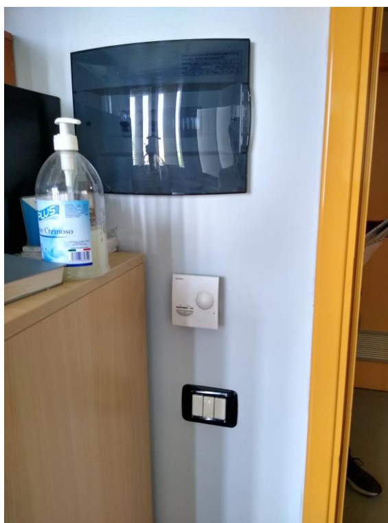
Tipico quadro elettrico di stanza ostruito da arredo
